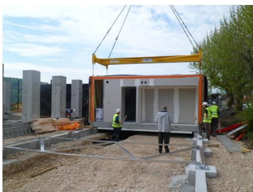
Pose des modules
