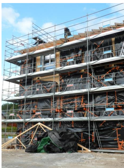
Toiture et finitions
